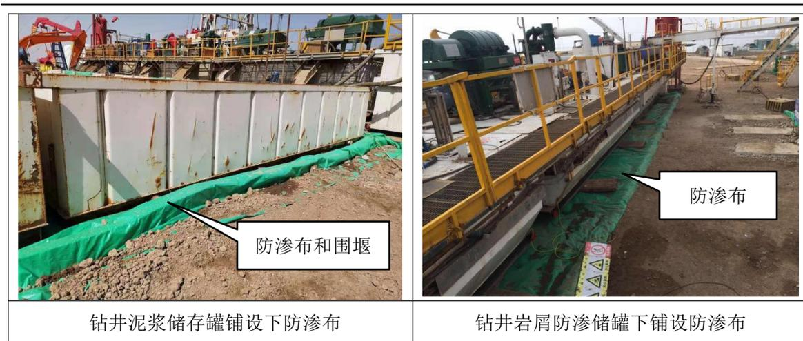
图 6.3-1 钻井过程中防渗储罐及防渗措施照片
