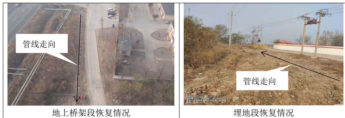
图 4-1 项目植被恢复情况图
